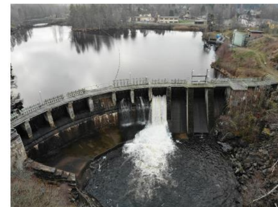
Hit men inte längre – dammen för Gullspång kraftverk.
