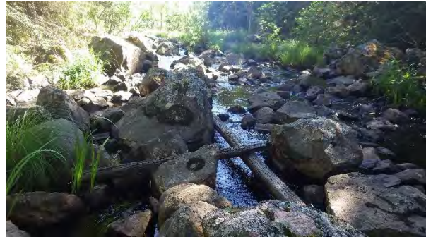
Lätt rensad, men sprängskadad sekvens av förgreningens nedre del.
