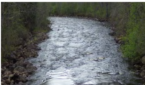
Pålströmmen i Testeboån före åtgärd. Enformig kanal innesluten av blockvallar.
