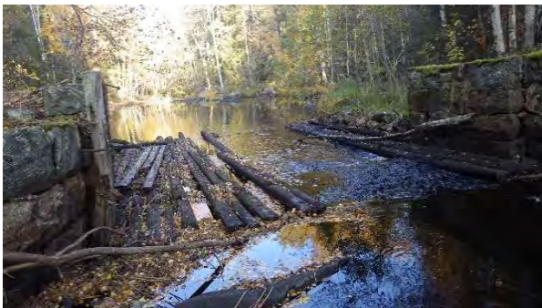
Utrivnen flottningsdamm vid Nydammens norra del.
