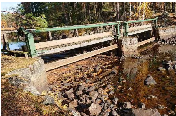
Tönnebrosjödammen vid lågvattenföring (höst 2018). Det enda vattnet som gick ut till Skärjån kom av läckage under dammens skibord.
