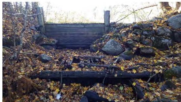
Plankfördämning i Nydammens södra del.
