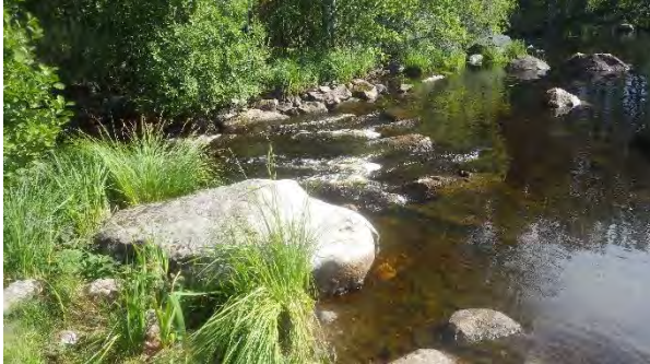
Fiskvandringsbar blocktröskel i Stor-Skärjans huvudutlopp.
