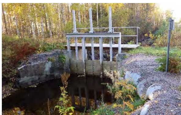
Regleringsdamm i Tönnebro sjöns utlopp mot Hamrångeån.
