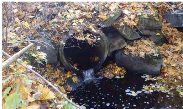
Dåligt anlagd trumma i bäck från Nydammen.
