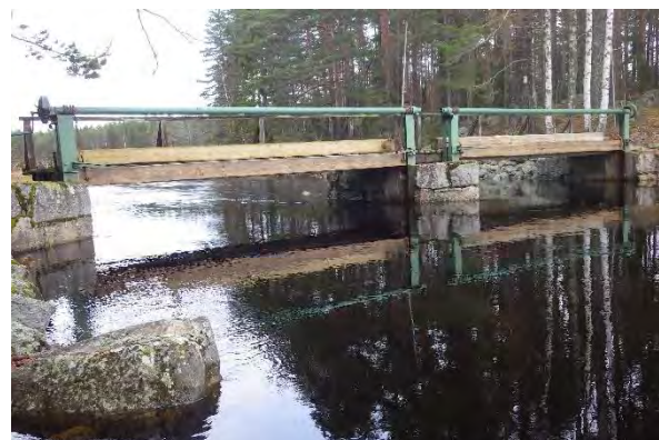
Tönnebrosjödammen under högvattenföring (höst 2017). På fotot syns tydligt att Tönnebrosjön och Kuttfjärden stod i samma nivå.
