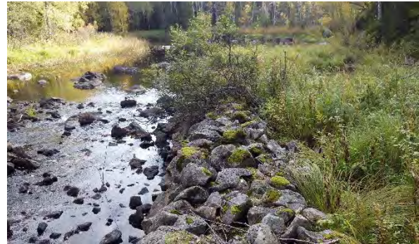
Exempel på en förhållandevis välbyggd och välbevarad ledarm i Skärjån (Kistströmmen).
