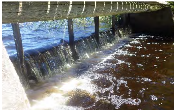
Överflödesdamm i Norans mellersta utlopp.
