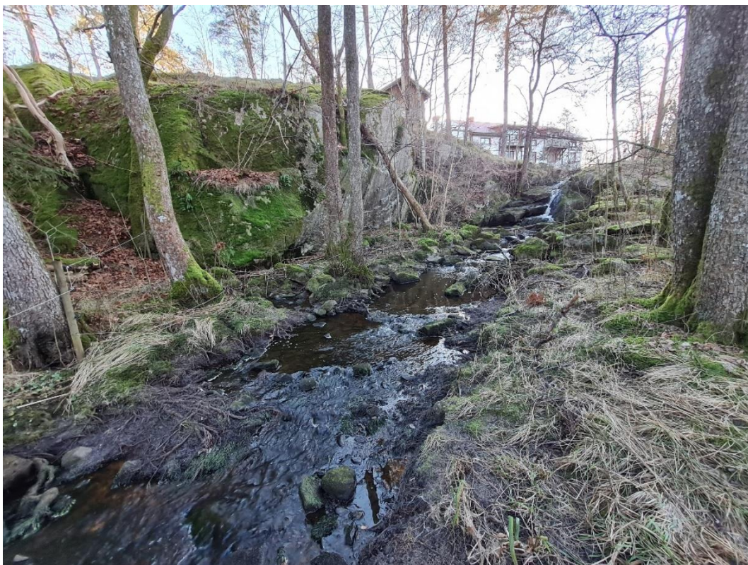
Figur 26. Västra fåran (spillfåran) vid Kollerö kraftverk med en svårpasserbar häll längst upp i bild.
