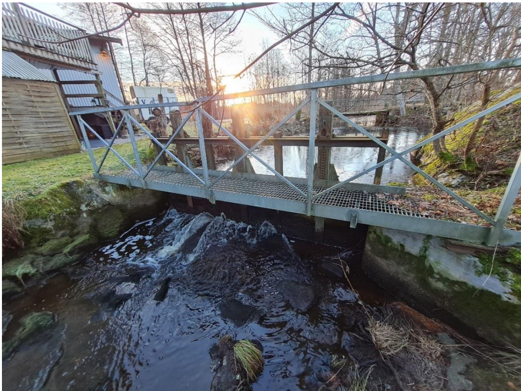
Figur 25. Regleringsdammen som styr flödet ned i västra fåran förbi Kollerö kraftverk i Risån.
