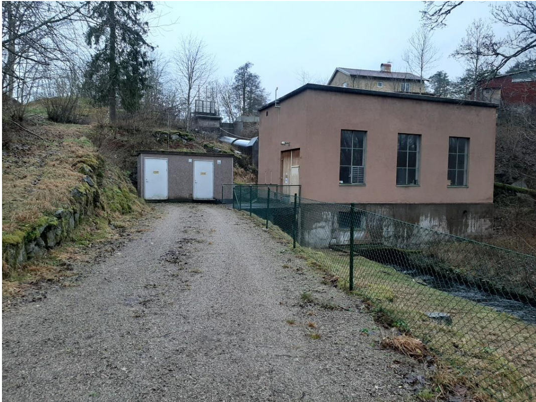
Figur 24. Kollerö kraftverk i Risån.
