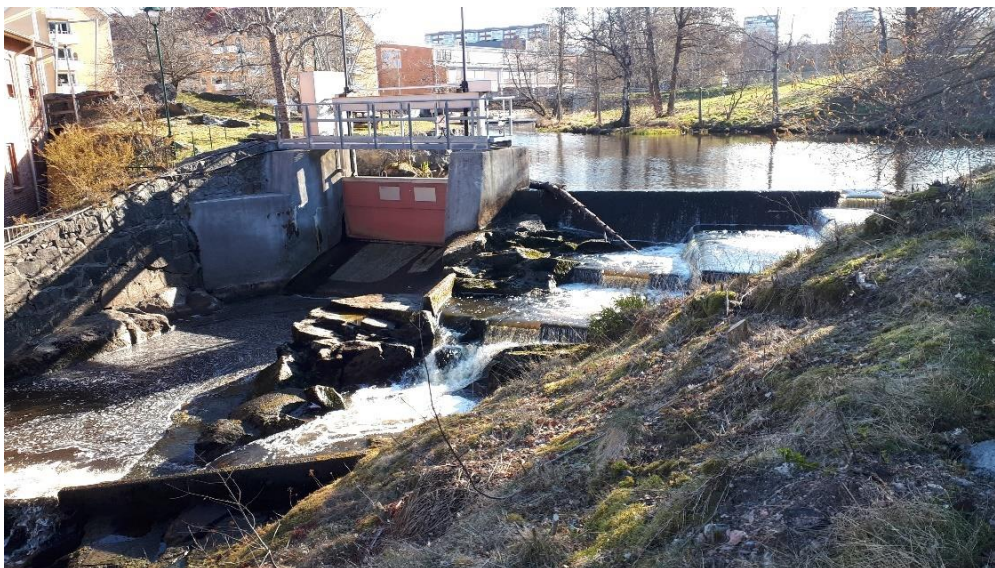
Figur 2. Strömbergets kraftverk i Bäveån, det första vandringshindret i Bäveån. En fiskväg finns anlagd.
