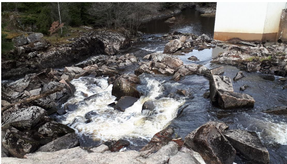
Figur 14. Groröds kraftverk, sträckan strax nedströms dammen. Bild från 2019.
