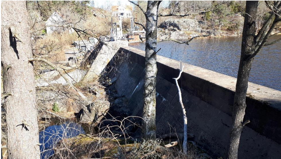
Figur 4. Dammen vid Fossumsberg kraftverk.
