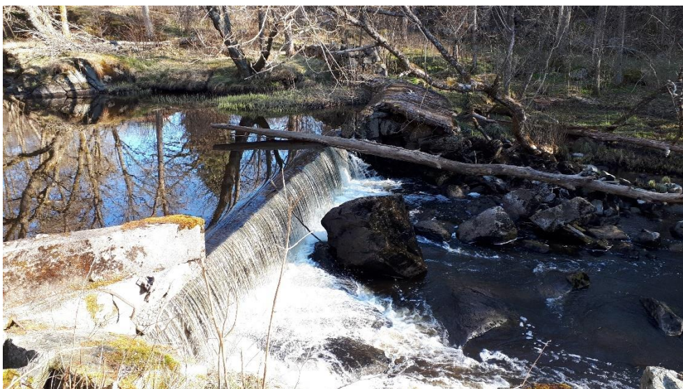
Figur 3. Damm vid Äsperöd, mellan S:t Anne äng och Fossums kvarn. Dammen revs ut under 2021.
