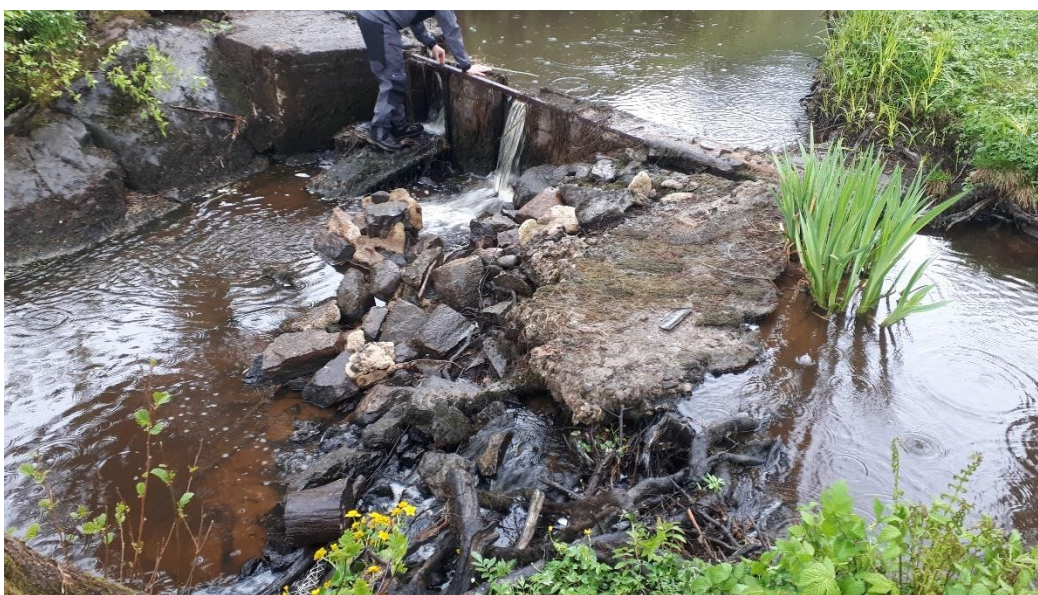
Figur 40. Andra vandringshindret i Kopperödsån vid slutet av sträcka 2, i form av en spegeldamm.
